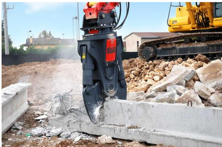
Рис. 2. Экскаватор с гидравлическими ножницами
