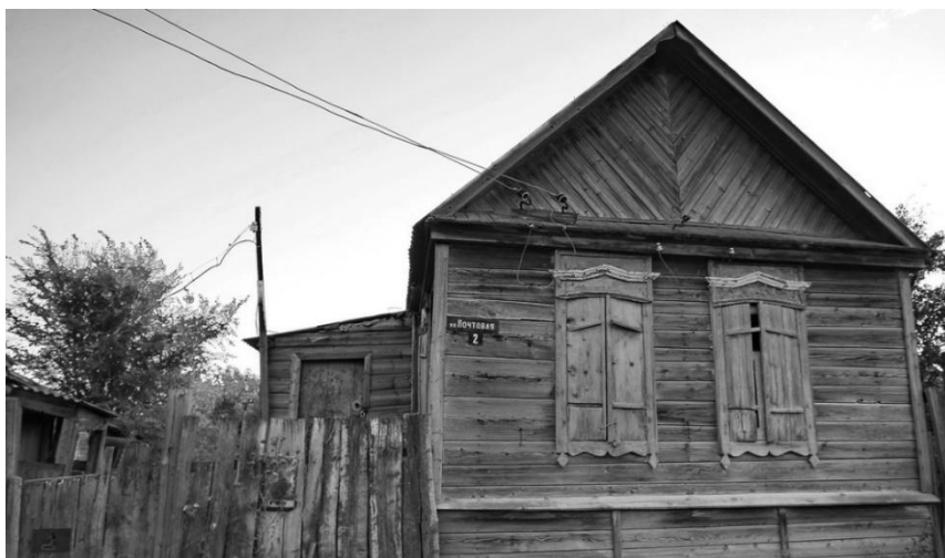
Рис. 2. Бесхозный дом, не отключенный от сети электроснабжения
