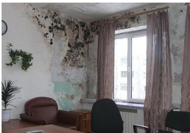
Рис.5. Образование плесени на внутренней поверхности стен
