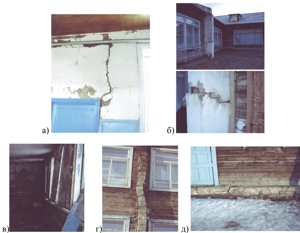
Рис. 1. Примеры аварийных состояний зданий в Республике Алтай: а) растрескивание и отслаивание штукатурки стен одноэтажного здания из бруса (с. Ортолык); б) трещина в поперечной кирпичной стене (брандмауре) одноэтажного здания (с. Онгудай); в) деформации простенков наружной продольной стены здания средней школы (с. Чаган-Узун); г) деформации контрфорса наружной продольной стены двухэтажного здания средней школы (с. Мухор-Тархата); д) трещины в фундаменте одноэтажного здания средней школы (с. Джазатор)
